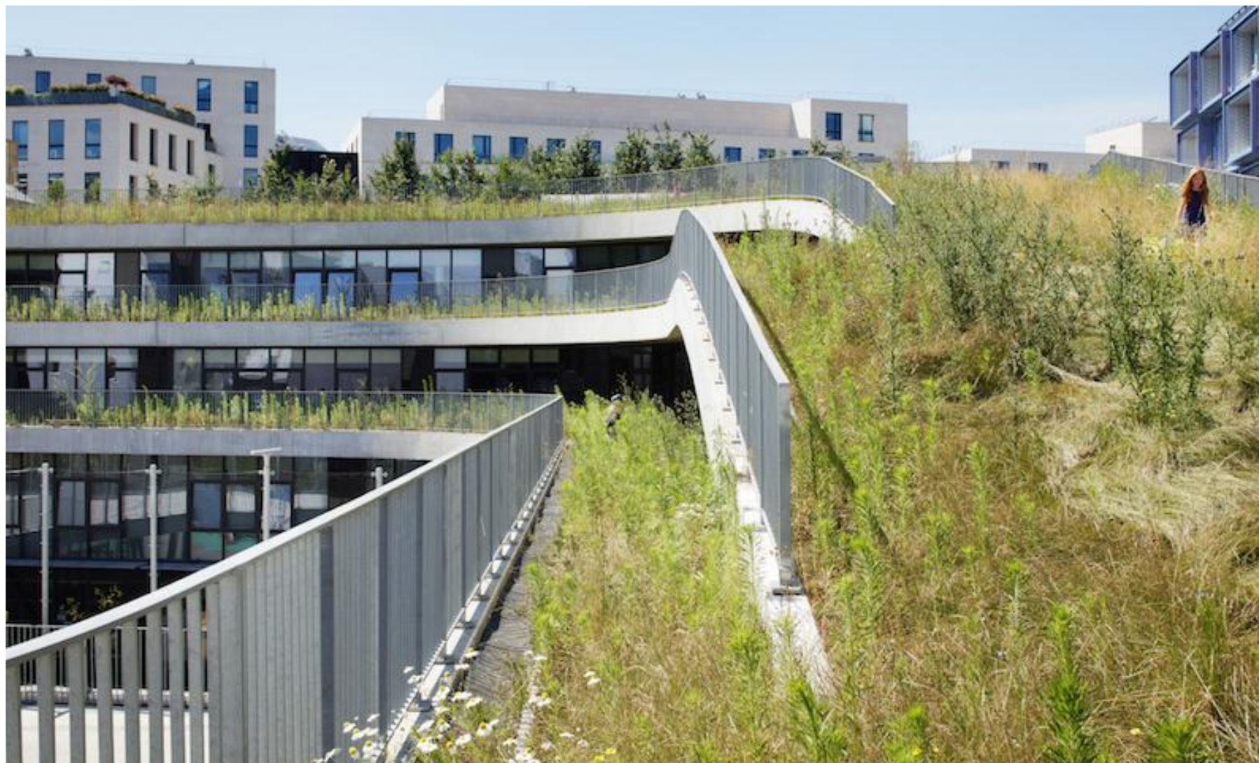
Detalle cubierta vegetal, Chartier Dalix, 2014
