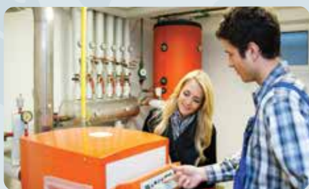
Soluciones de agua caliente centralizada (caldera) y paneles solares.
